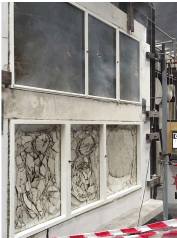
BRANDVINDUER // DBI TEST
