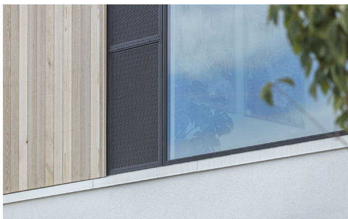
SPECIALLØSNING // NATURLIG VENTILATION
